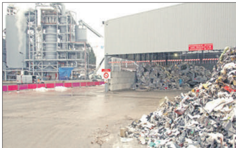
La centrale cogénération transforme les déchets du bâtiment en énergie propre.
